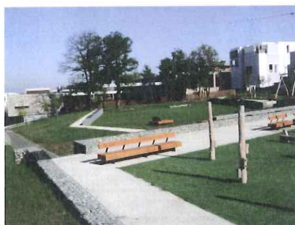
Bassin de rétention – Écoquartier Balma-Gramont Source : Toulouse Métropole (Direction du Cycle de l'Eau)
