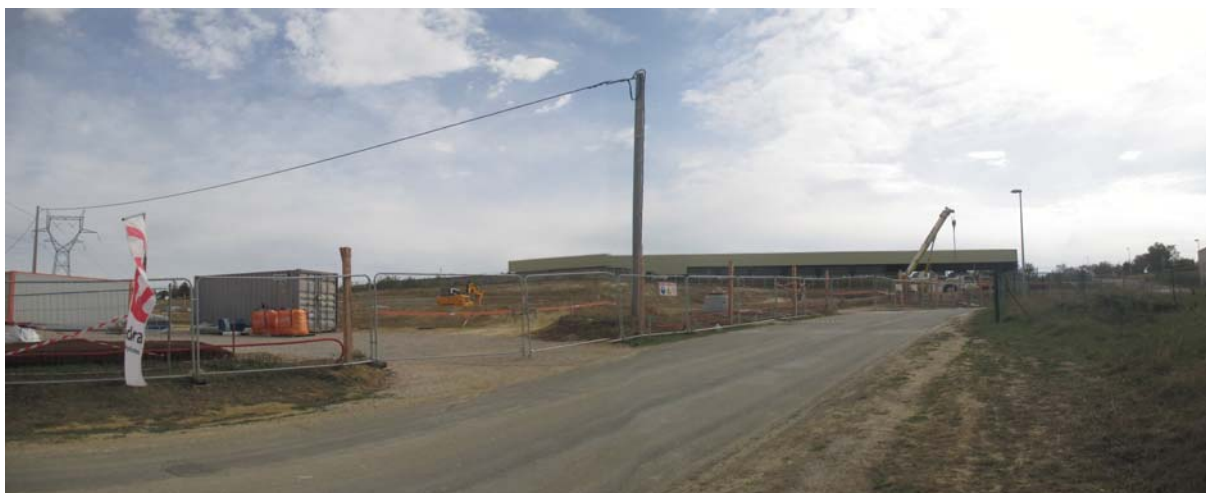
Illustration n° 26 : nouveau bâtiment d'activités en construction
