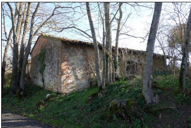
Construction ancienne près du clocher qui pourrait être valorisée
