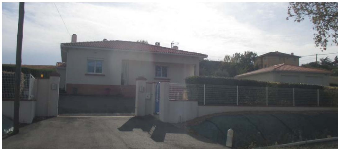
Illustration n° 17 : vue sur le quartier en Broumelle, depuis la RD1
