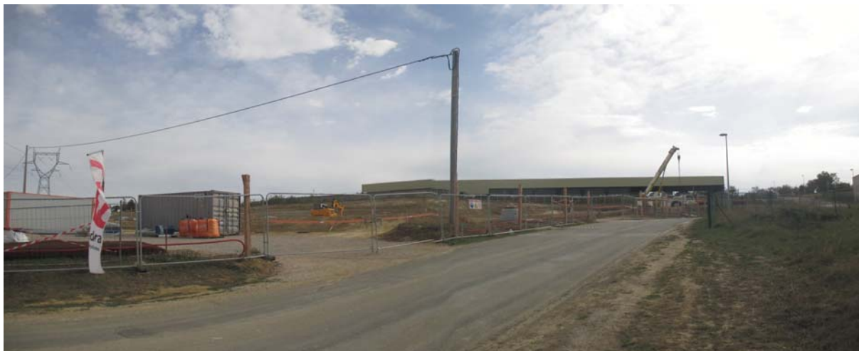
Illustration n° 26 : nouveau bâtiment d'activités en construction
